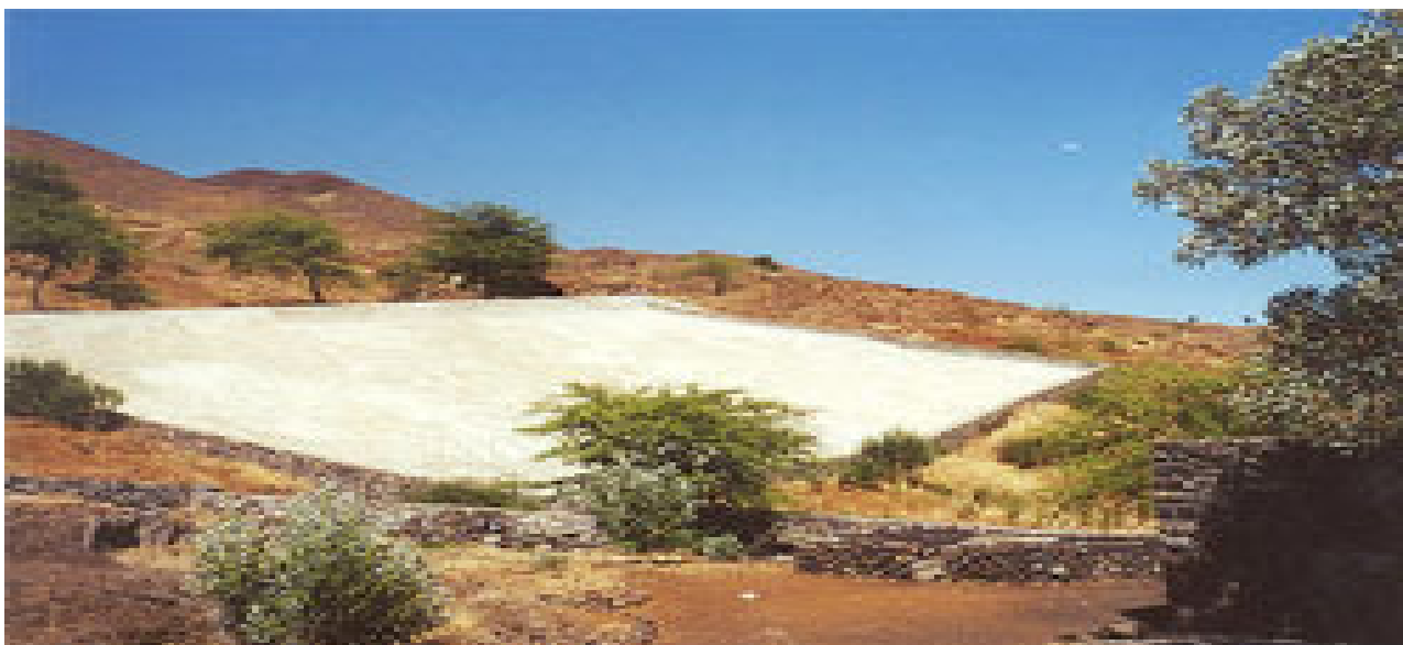
Reservatório de água da chuva na Ilha de Fogo (Cabo Verde).
